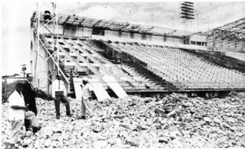
ESTADIO JUAN DEMOSTENES AROSEMENA - Las obras de re- modelación de las gradas y del campo de Beisbol del viejo Esta- dio, que fue el escenario principal de los Cuartos Juegos de 1938 en Panamá.
