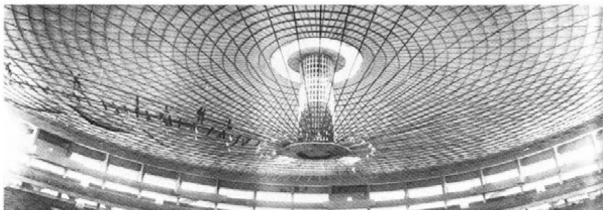
GIMNASIO NUEVO PANAMA. Vista interior del techo.
