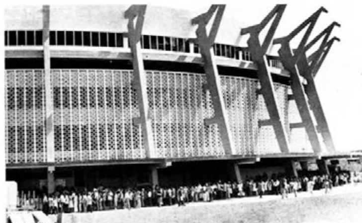
Cola en las boleterías del Gimnasio
