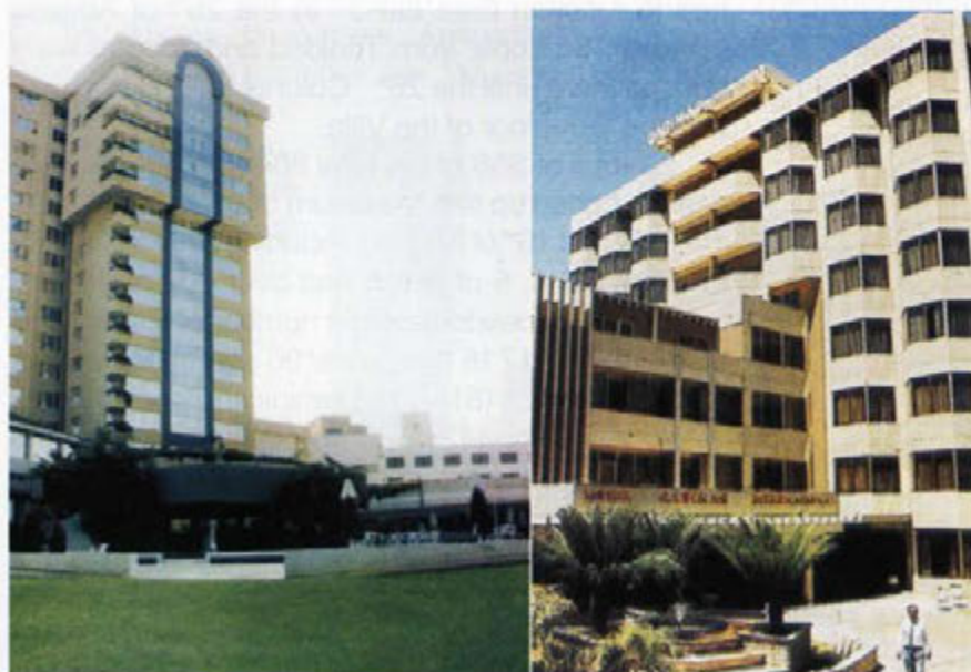
Hotel Maruma (Maracaibo) y Hotel Cabimas Internacional / Maruma Hotel and Cabimas International Hotel
